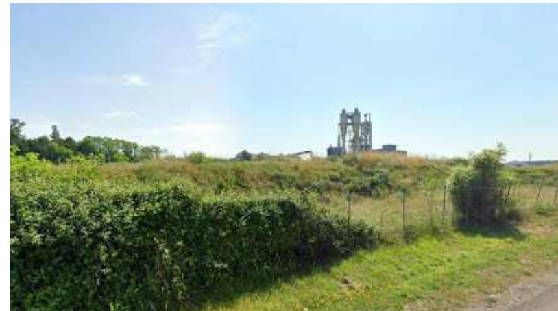
Vue des installations depuis les premières habitations au Nord-ouest
