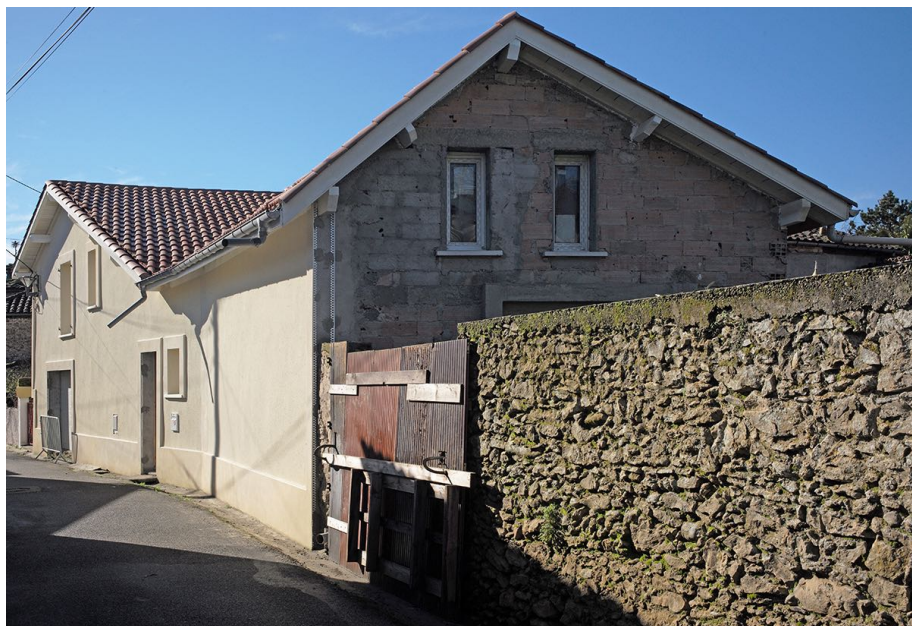
Exemple d'une rénovation peu qualitative : rue Capet
