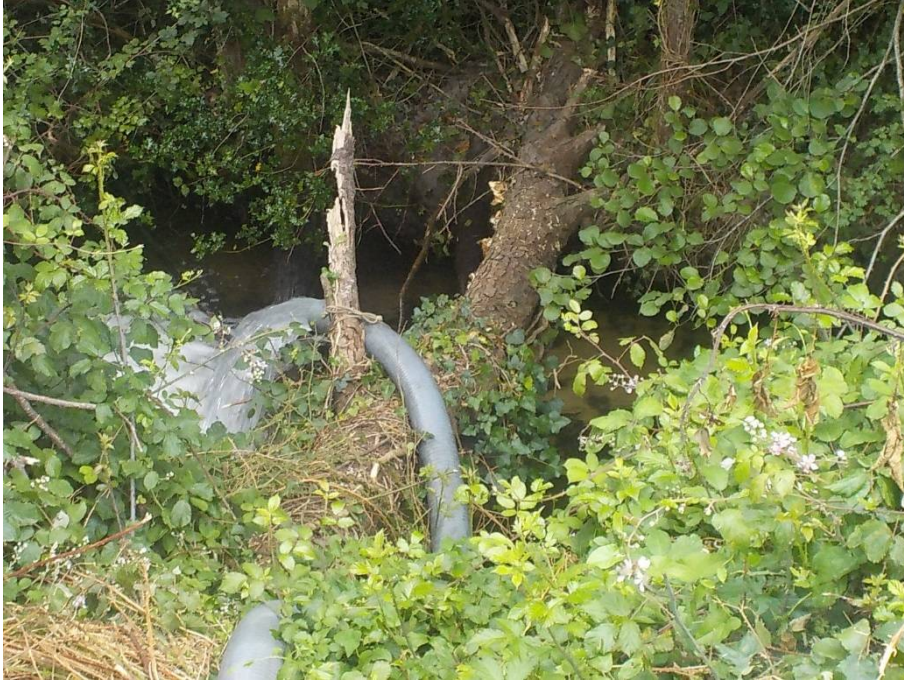
Rejet du pompage longue durée (81 m 3 /h)
