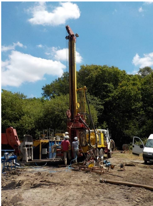
Installation de la pompe dans le forage (28 juin 2016)
