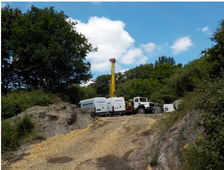
Chantier du forage (28 juin 2016)
