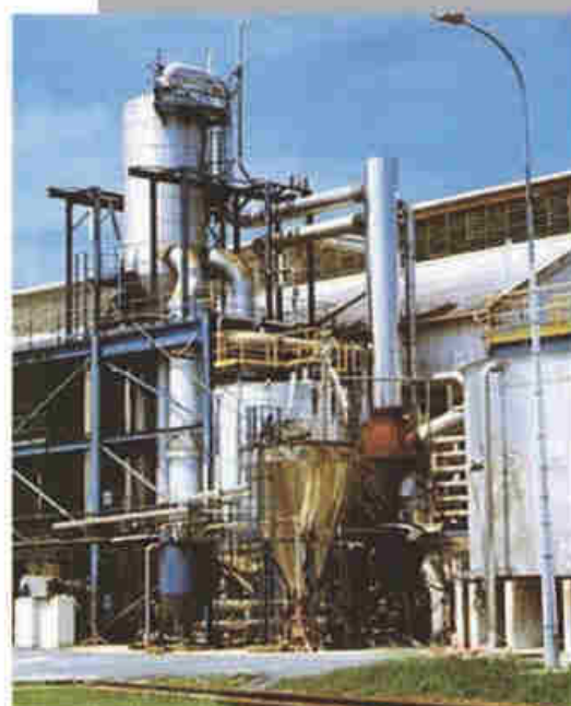
Usine saline de Saint-Pandelon (© www.salins.fr )
