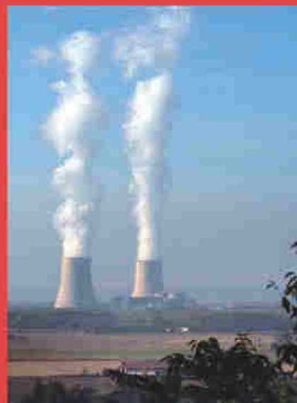
Centrale nucléaire de Golfech (source : wikimedia commons)
