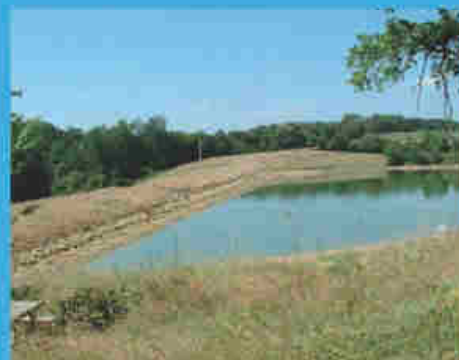
Barrage de Arthez (© DDTM40 - SPE)
