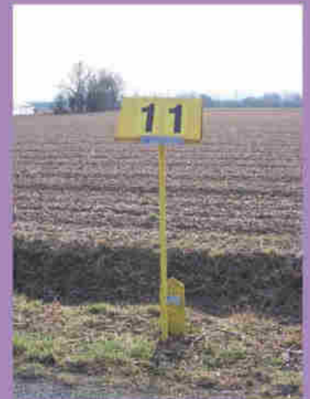
Borne de localisation d'un pipeline (© Alp/Géorisques)
