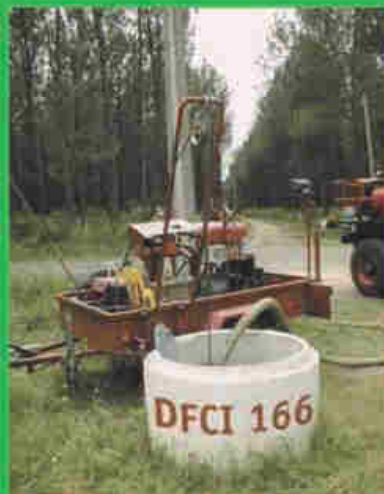
Point d'eau DFCI (© DFCI Aquitaine)
