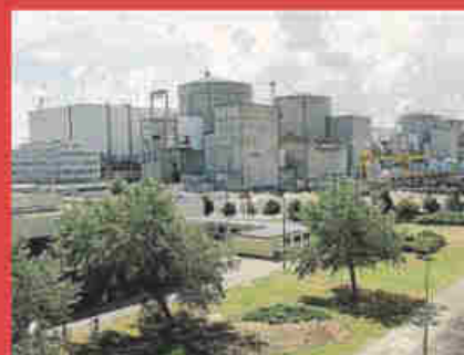
Centrale nucléaire du Blayais (source : wikimedia commons)
