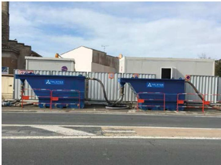
***Photographie d'une installation de traitement avec 2 décanteurs lamellaires pour 100 m<sup>3</sup>/h***
