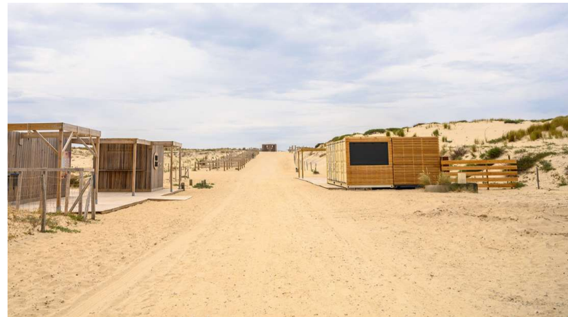
Raccordement accès plage du Vivier
