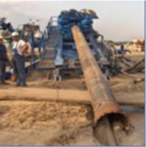
Forage dirigé Washover
