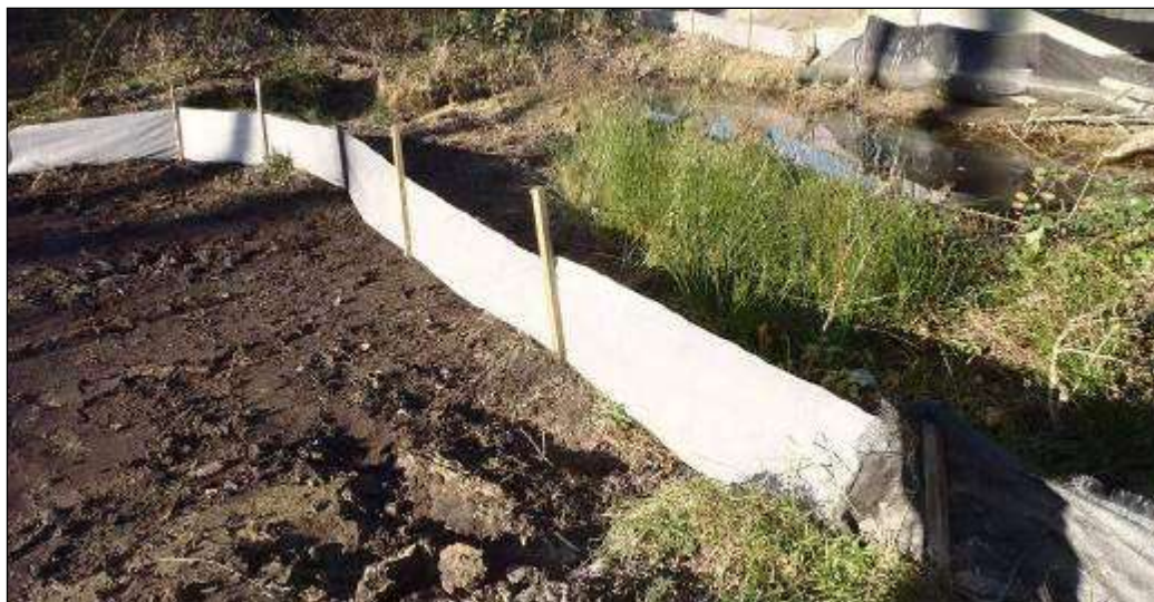
Implantation de barrières amphibies en géotextile permettant d’éviter les déplacements des individus du cours d’eau vers le chantier © ETEN Environnement
