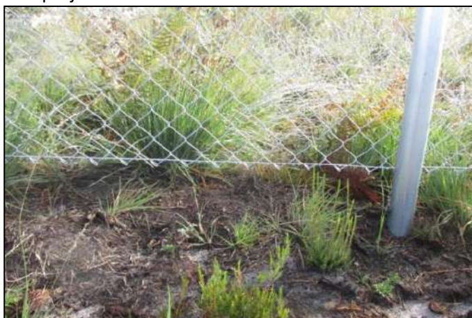
Exemple de clôture perméable © ETEN environnement
