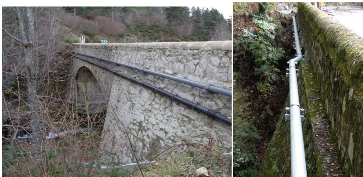
Exemple d’encorbellements tubulaires Source : https://metallerie-jbs.com
