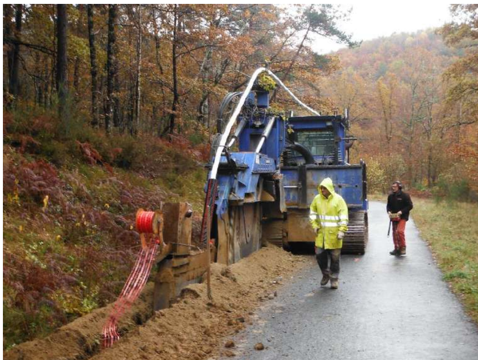
Exemple de pose de câble à la trancheuse
