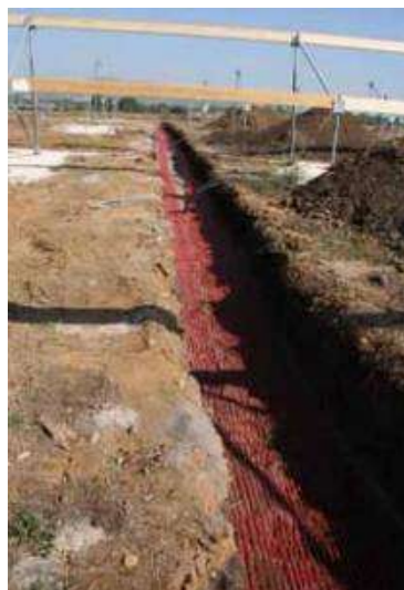
Ouverture d’une tranchée pour l’enfouissement des câbles
