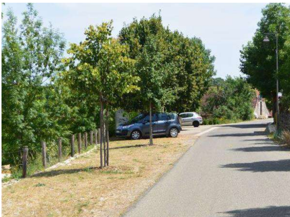
Figure 121 : Places de stationnement en revêtement terre/pierre
