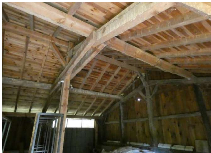
Figure 66 : Intérieur du garage du bâtiment 4 (Source : Simethis)
