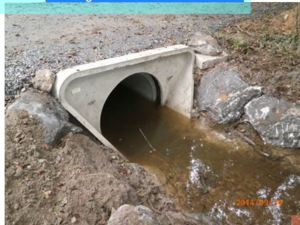
Ouvrage de franchissement bien calé
