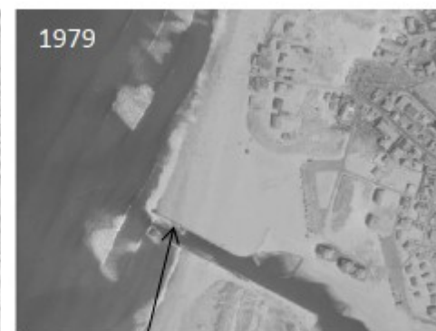
Digue Nord (construction 1979)
