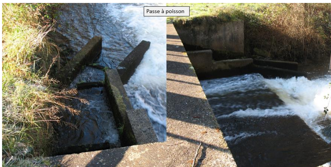
Photo 5/6 : Passe à poisson et aval du barrage
