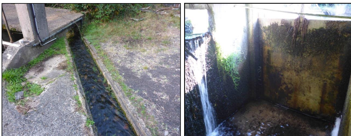
Figure 7 : Entrée et sortie du canal de défeuillage
