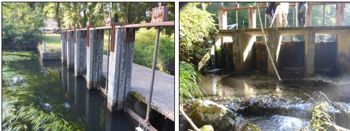
Figure 4 : Seuil et ses vannes – vue de l'amont et de l'aval
