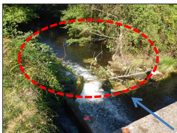
Figure 20 : zone d'enrochements à mettre en place
