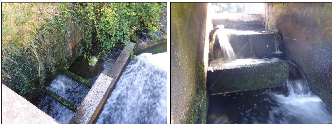
Figure 5 : Passe à bassins vue de l'amont et premiers bassins vus de l'aval
