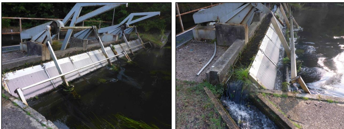
Figure 6 : Grille et canal de défeuillage
