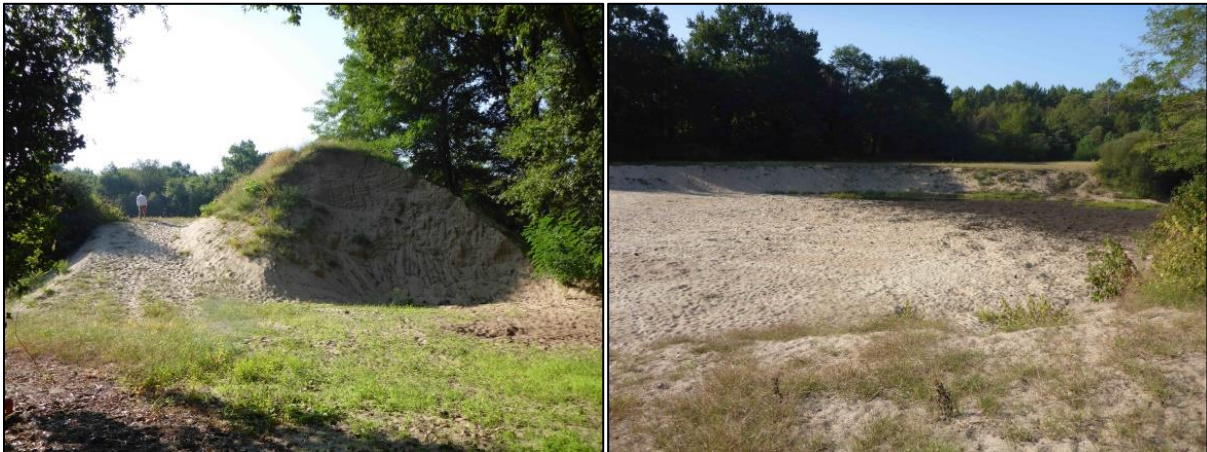
Figure 12 : zone de stockage du sable
