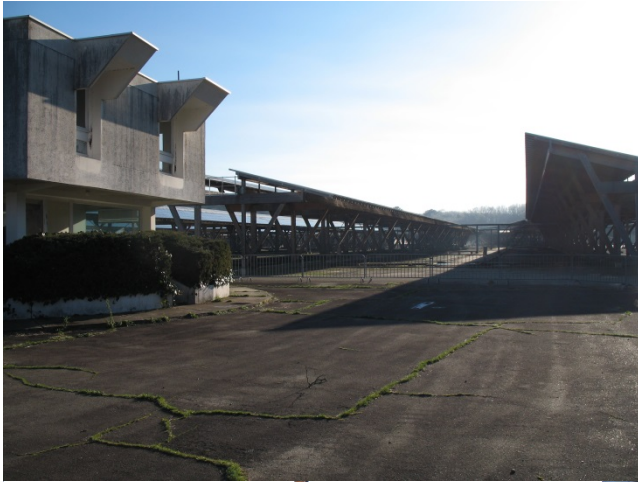
Photos : vues globale du site
