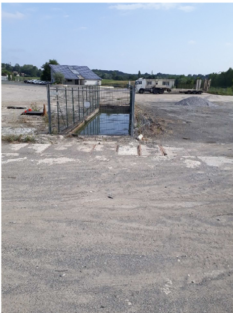
Bassin réserve d'eau 100 m3
