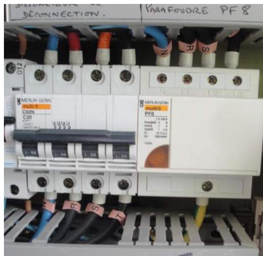
Photo n°3 : Parafoudre sur station de carburants
