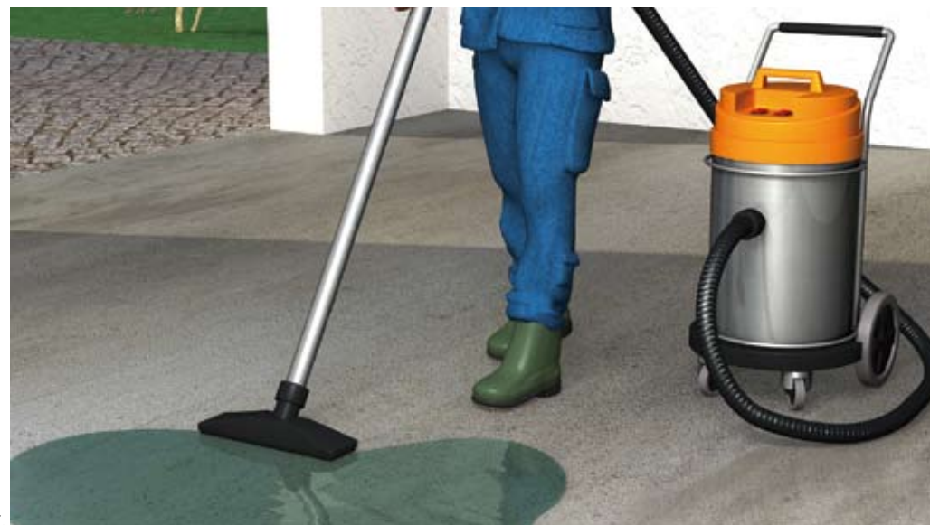
Elimination des eaux résiduelles au RDC.
