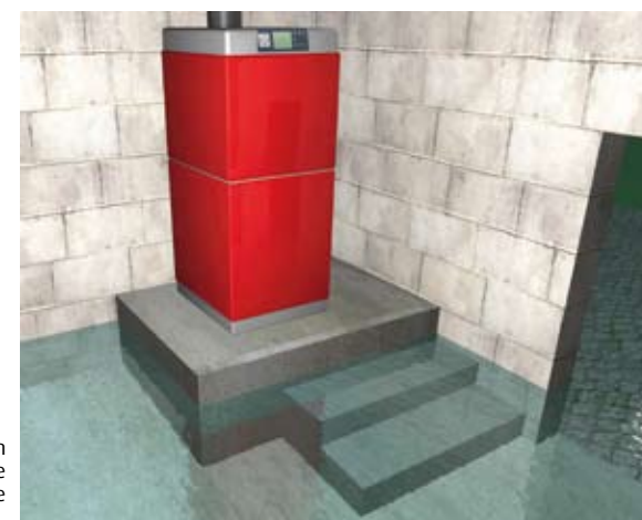
Protection d'un équipement de chauffage par surélévation.
