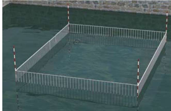
La barrière de sécurité reste visible tant que le niveau de l'eau est inférieur à sa hauteur
