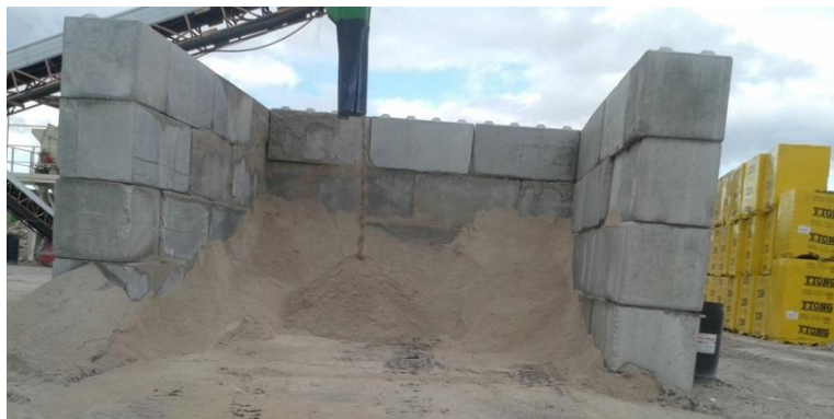
Figure 26 : Stockage en casier
