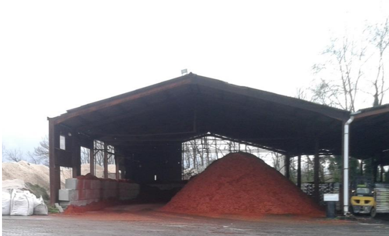
Figure 25 : Stockage sous abri
