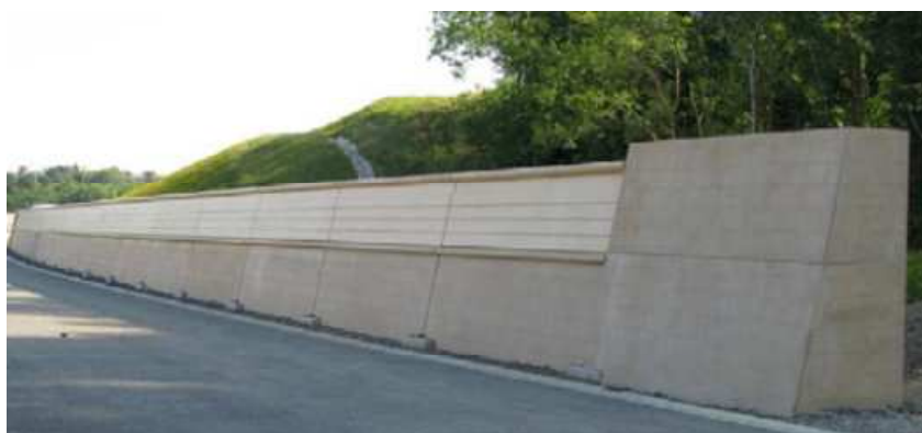
Figure 9 : Effet du merlon acoustique en bordure de voie (Intégrative AVF Ingénierie)
