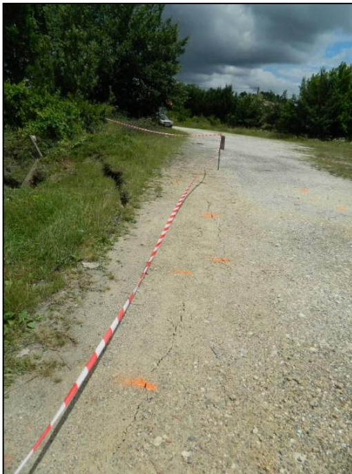
Figure 44 : Fissuration sur un chemin (photo de droite) et sur le bâti (photo de gauche) en périphérie des effondrements [Source : BRGM]
