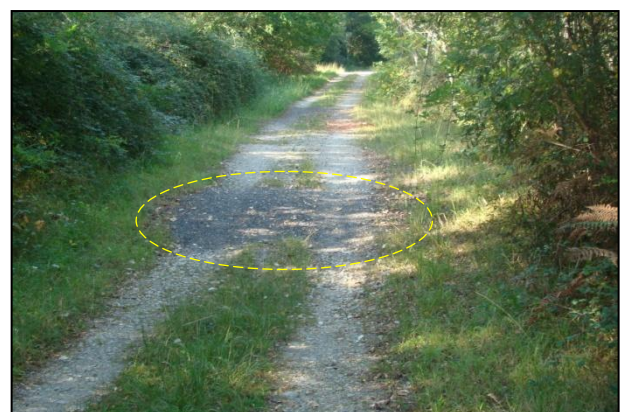
Figure 65 : Zone remblayée sur un chemin à l'Est de SOCODAC [Source : IMS RM ]
