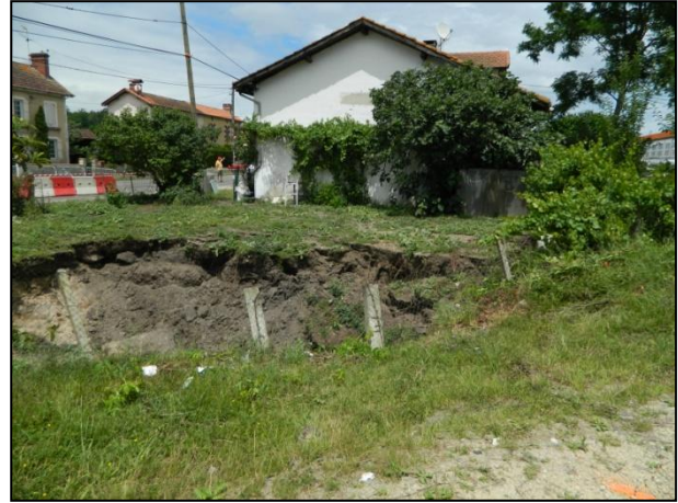
Figure 43 : Effondrements survenus le 6 juillet 2012 à proximité de l'avenue Gaston Lescouzères. Celui au premier plan correspond au premier événement, le seconde est visible en arrière-plan sur la photo de droite [Source : BRGM]
