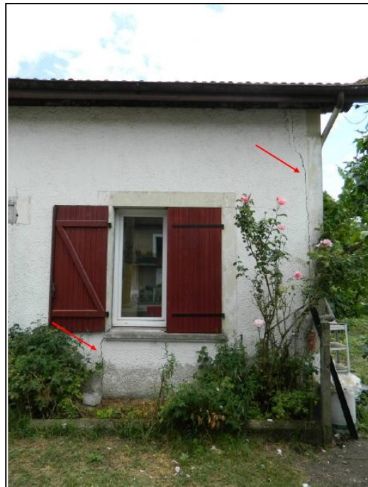
Figure 44 : Fissuration sur un chemin (photo de droite) et sur le bâti (photo de gauche) en périphérie des effondrements [Source : BRGM]
