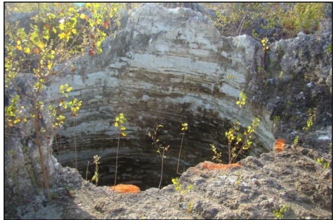
Figure 63 : Evolution du fontis n° 6 entre le 1 er juin 2012 (à gauche) et le 12 septembre 2014 (à droite) par effondrement de la couverture des déchets de papeterie [Source : BRGM / IMS RM ]
