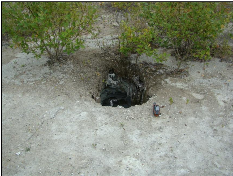
Figure 62 : Dépression présentant un effondrement d'environ 1 m de diamètre au centre, les parois présentent un dévers marqué s'étendant à plusieurs mètres autour du fontis (désordre n° 3 dans l'étude BRGM) [Source : IMS RN ]
