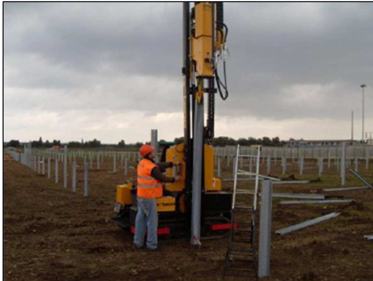
Exemple de pieux vibrofoncés (Source : ENGIE Green)
