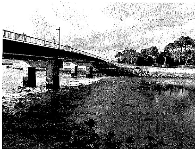
Seuil du pont de Notre Dame (Source Photo : ARGE0 le 4/01/2018)
