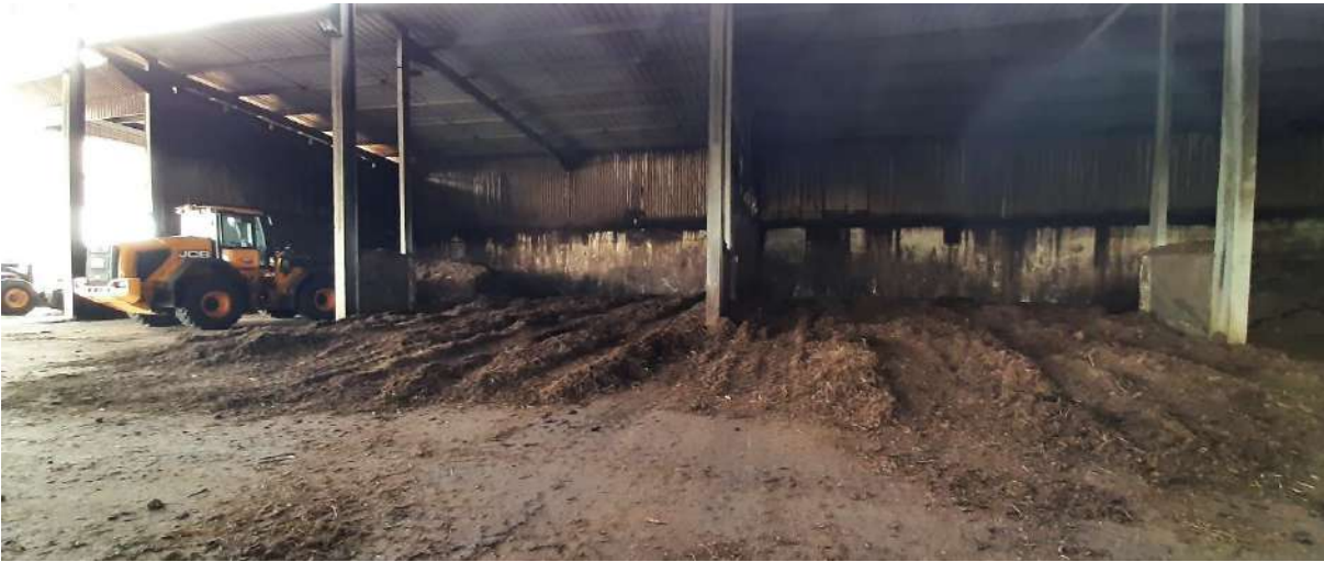
Figure 6 : Lits de co-structurants pour mélange avec les boues
