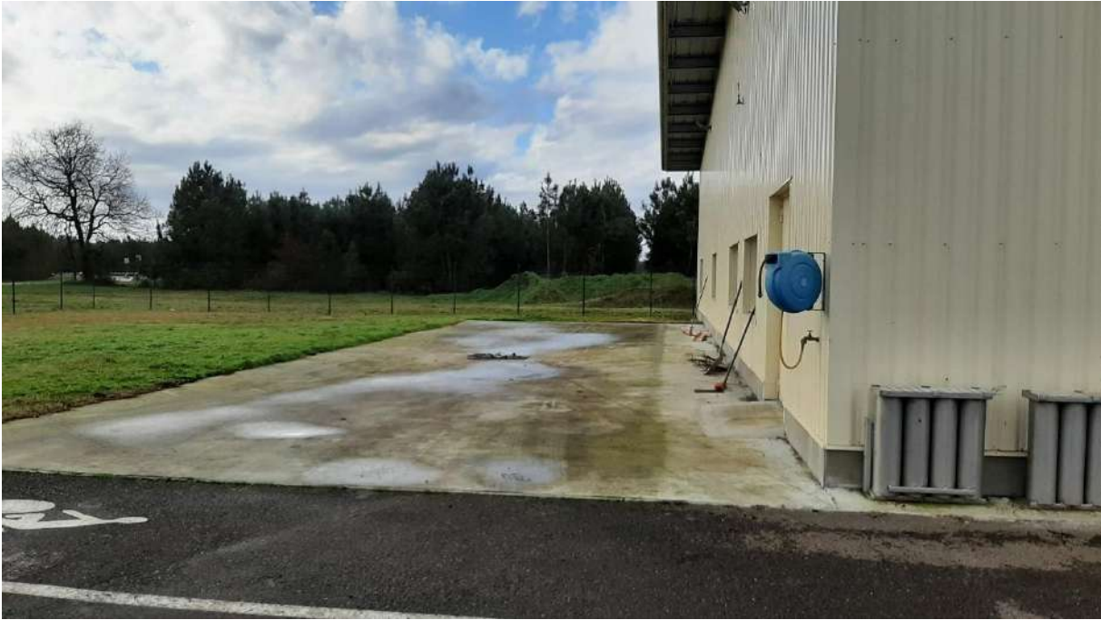
Figure 16 : Aire de lavage de l'usine de compostage de Thalie
