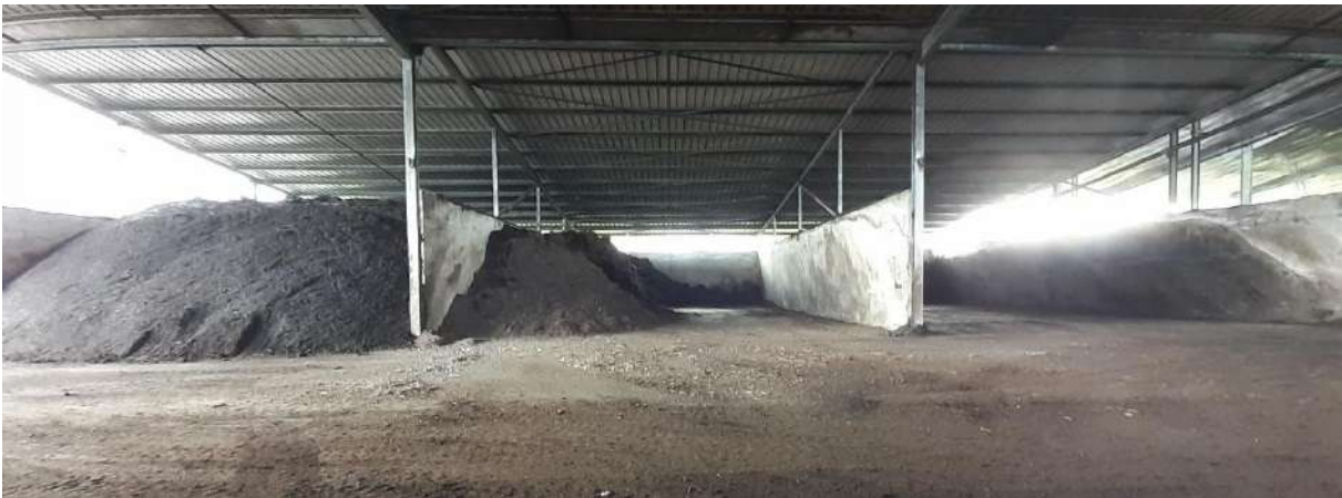
Figure 12 : Trois box de stockage du compost fini de l'usine de compostage de Thalie
