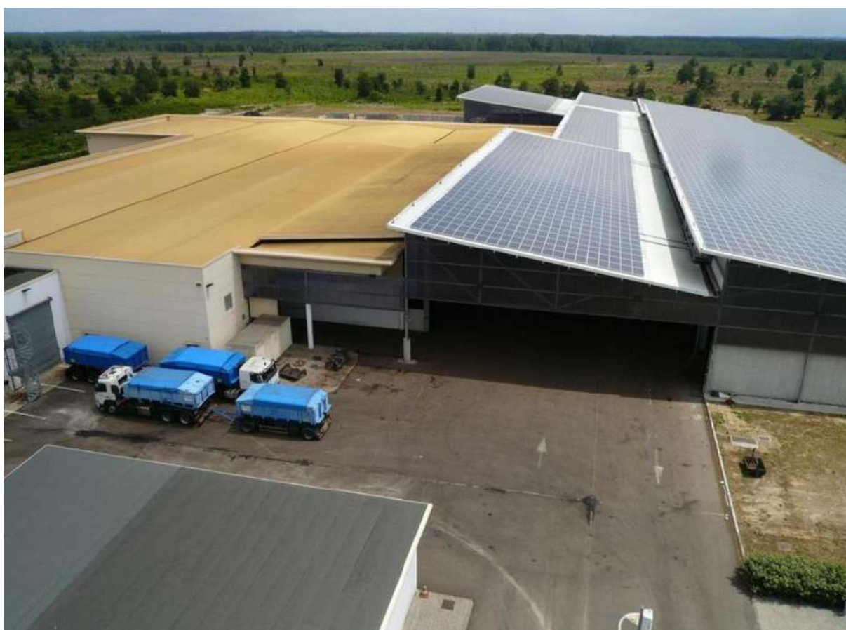
Figure 19 : Installation photovoltaïque en toiture du bâtiment principal de l’usine de compostage de Thalie (source : sydec40)
