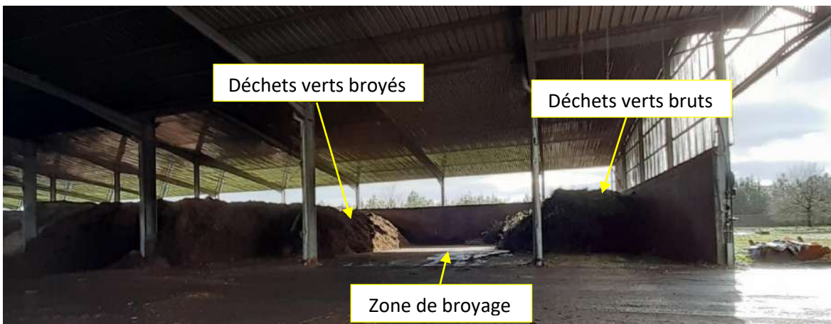
Figure 5 : Zone de stockage et broyage des déchets verts
