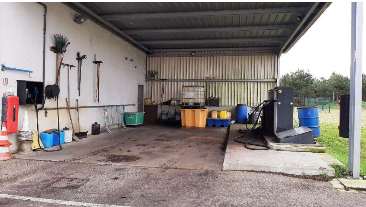
Figure 18 : Station de carburant de l'usine de compostage de Thalie
