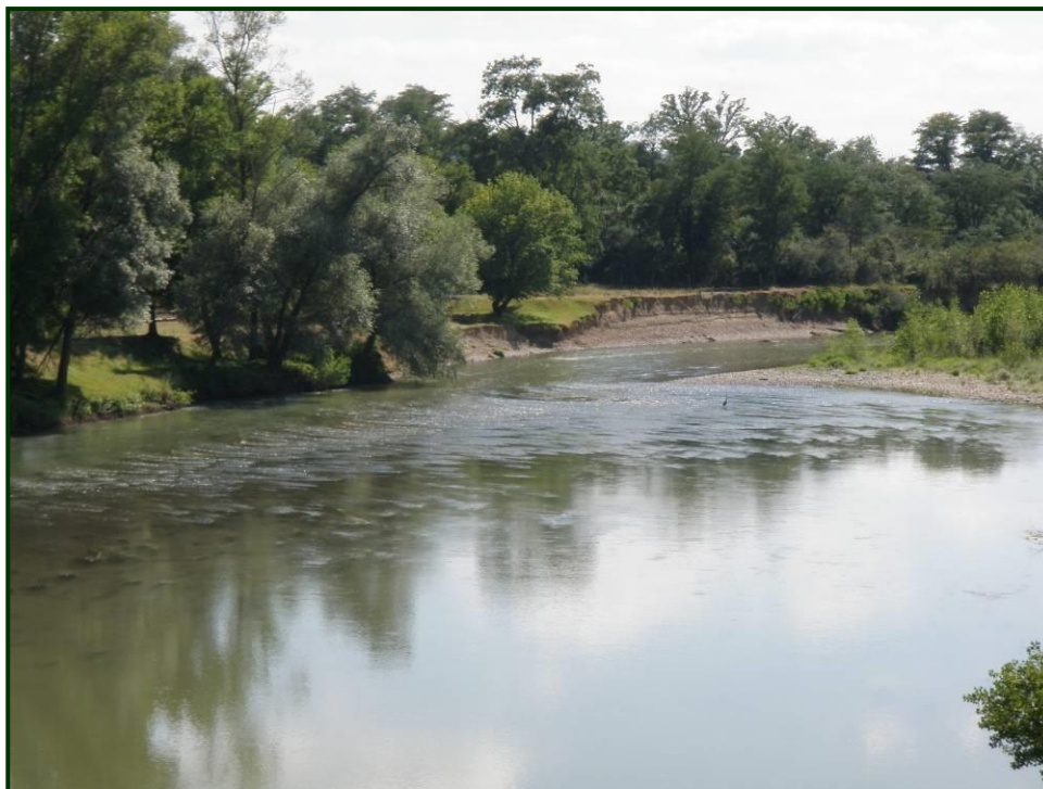
Figure 31 : Glissement en rive gauche de l’Adour, en aval du pont des carrières Lafitte (12 juillet 2012)
