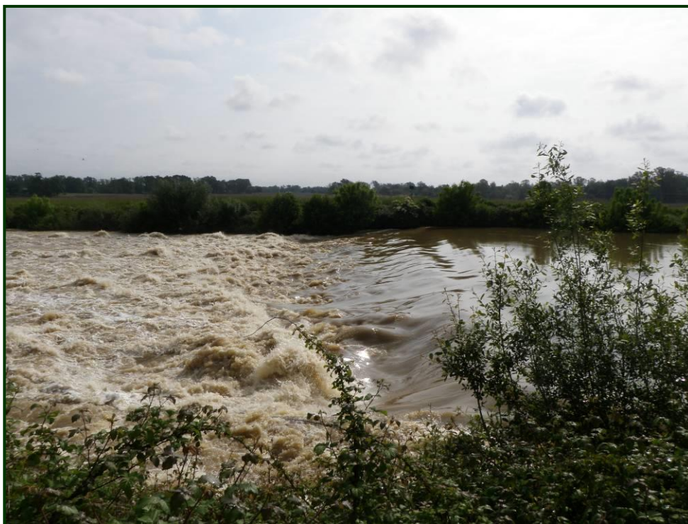
Figure 29 : Seuil d’Augreilh (petite crue du 23 mai 2012)
