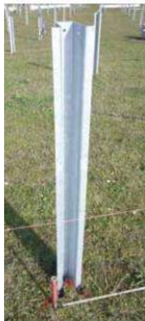
Pieu pour les fondations réduisant les impacts sur l’imperméabilisation des sols
