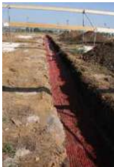
Ouverture d'une tranchée pour l'enfouissement des câbles
