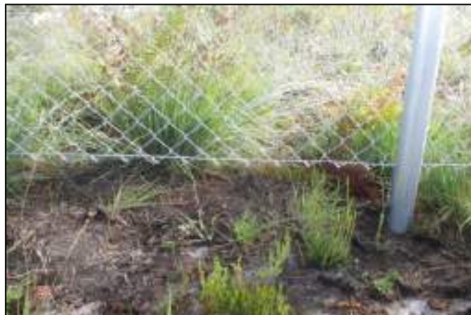
Exemple de clôture perméable © ETEN environnement
