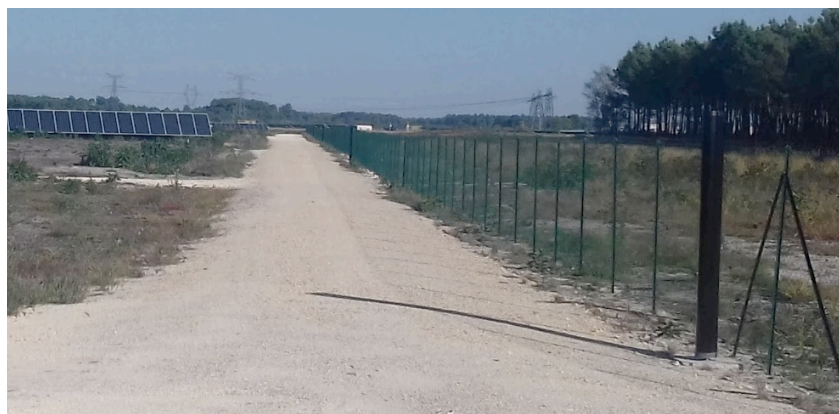
Photo 3 : Exemple de chemin intérieur dans une centrale
