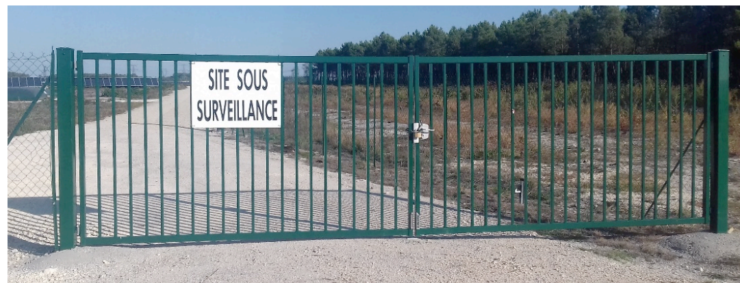
Photo 4 : Portail d'entrée dans le parc photovoltaïque
