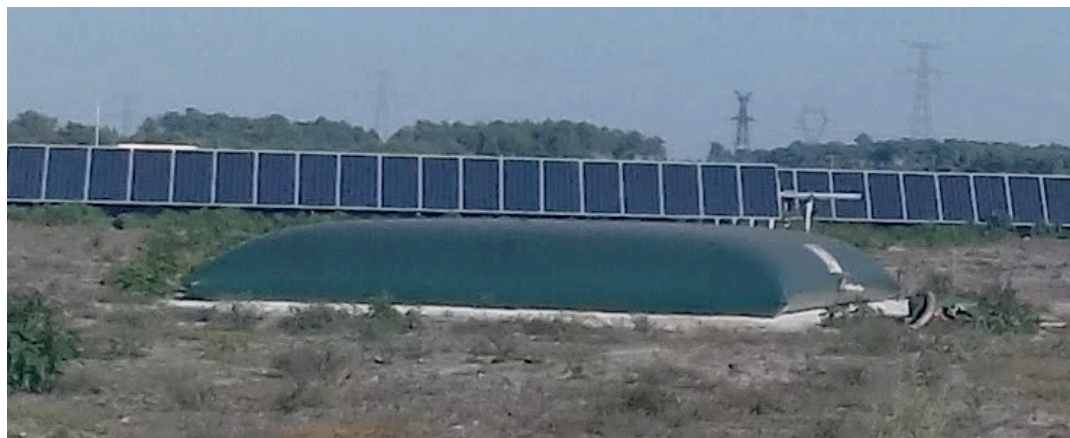
Photo 1 : Exemple de bâche à eau dans une centrale photovoltaïque
